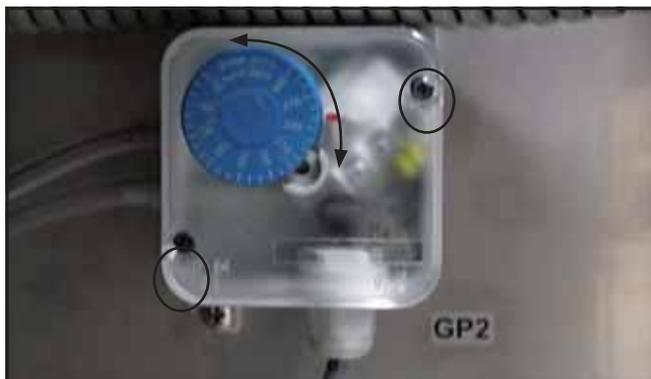
Zur Änderung der Druckeinstellungen, lösen Sie zunächst die beiden Schrauben und entfernen dann die Abdeckung. Drehen Sie nun an dem blauen Rad, bis die von Ihnen gewünschten Einstellungen erreicht sind.
